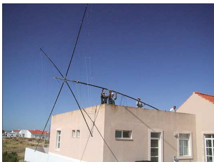
Aufrichten des Mastes mit Spiderbeam auf dem Flachdach des Kindergartens. Fotos: HB9CRV
