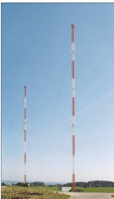
Antennenanlage des Senders im September 2003. Im Vordergrund befindet sich der Sendemast und dahinter der gleichhohe Reflektormast. Foto: Lutz
